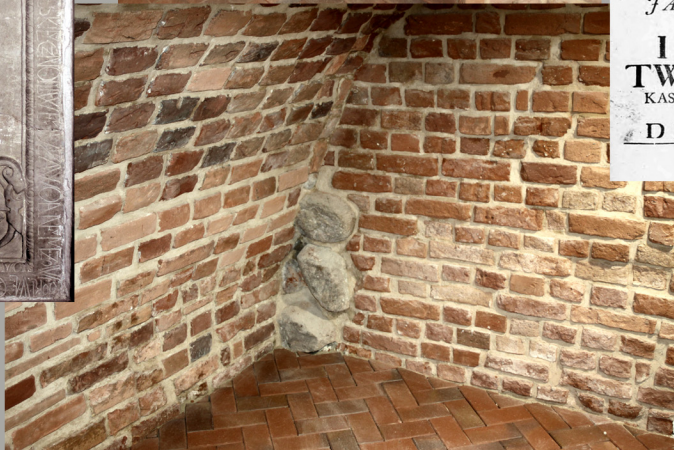
Zachowane w piwnicach obecnego pałacu fragmenty piwnic dawnego dworu Twardowskich z przełomu XVII/XVIII wieku
