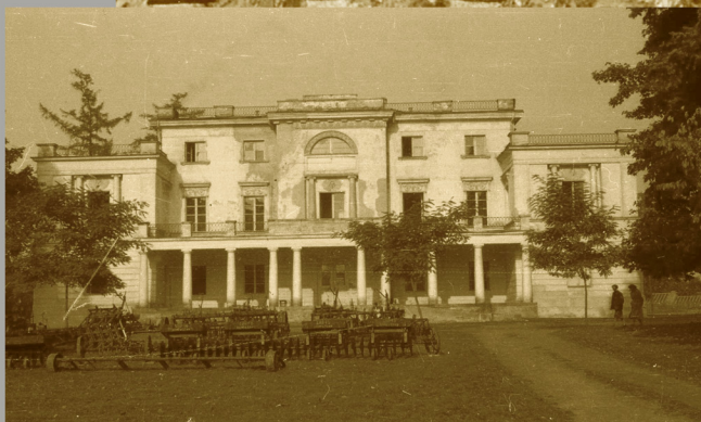
Widok fasady pałacu około połowy lat 50. XXw.
